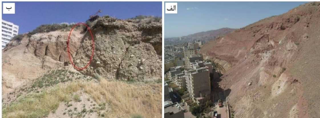
شکل ۲. نمونه‌ای از ساخت‌وساز در پهنه گسل در شهرهای لرزه‌خیز ایران. الف) ساخت‌وساز در شهرک باغمیشه روی پهنه گسله در شیب دامنه محل عبور گسل شمال تبریز، ب) مجاورت گسل با برج‌های ونک پارک واقع در تقاطع همت - شیخ بهائی در شهر تهران (عکس از علی بیت‌اللهی)
